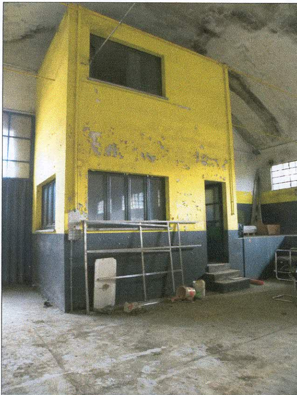
Veduta dell'interno del capannone
