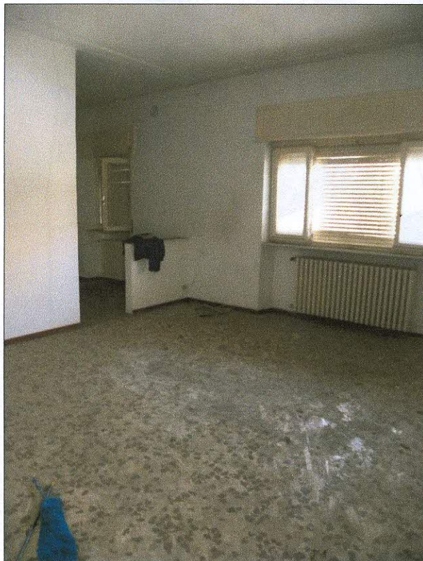
Veduta dell'interno del fabbricato residenziale
