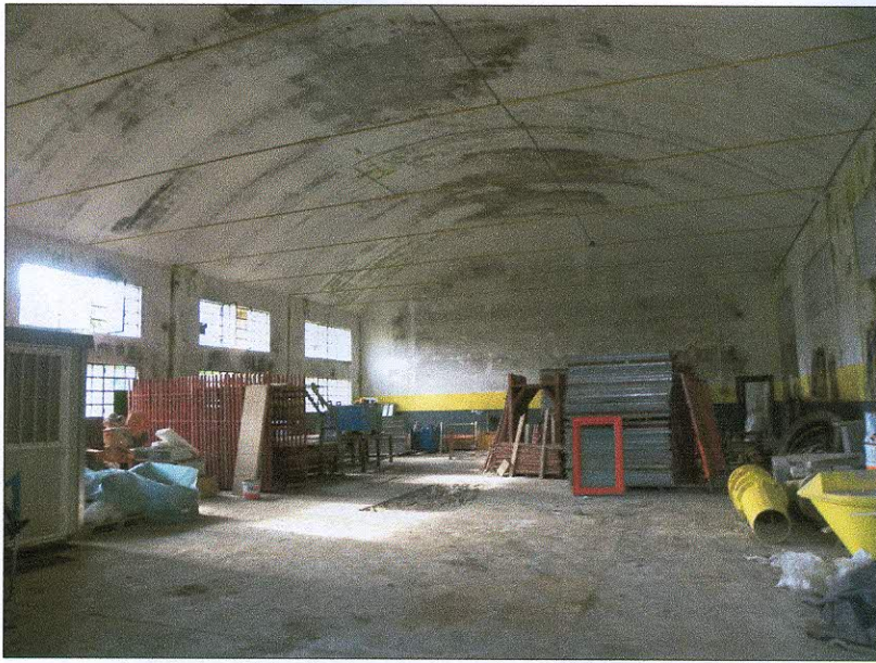
Veduta dell'interno del capannone
